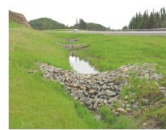
Bernes en escalier - Source : MTQ Estrie
